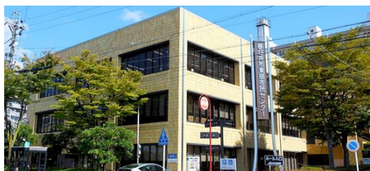
☆東部市民センター図書室
